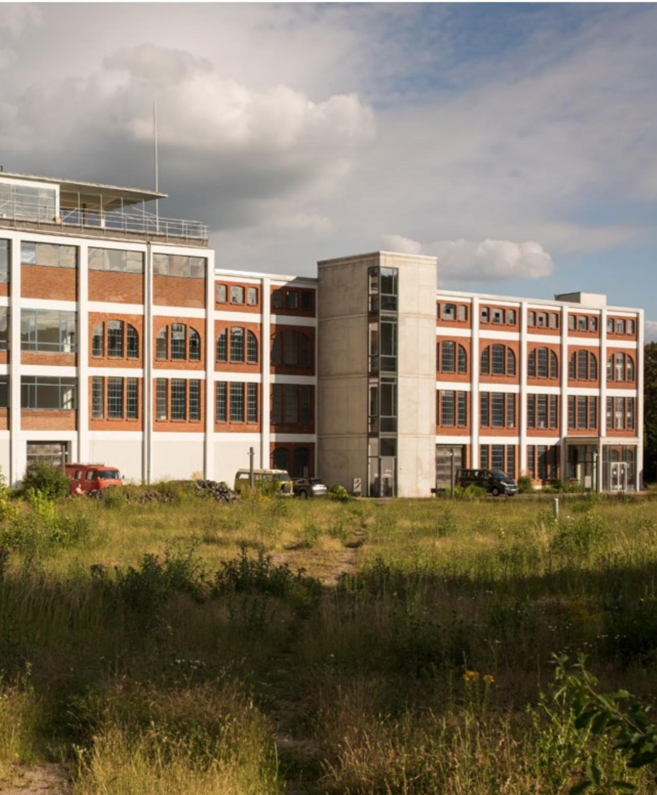
An der Fassade lassen sich die beiden Bauphasen der Fabrik gut ablesen. Links der sachlich moderne *Eiermannbau* (fertiggestellt bis 1939) mit der großzügigen Dachterrasse, rechts der *Schneiderbau* (um 1907) mit seiner historisierenden Fassadengliederung. Auf der der Straße abgewandten Seite entschied sich Egon Eiermann die beiden unterschiedlichen Bauauffassungen bewusst als Übergang an drei Achsen sichtbar zu machen. An der Straßenseite fehlt dieser Eingriff.
