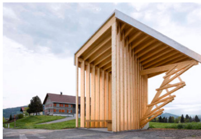
Abb. 12: Bushaltestelle in Krumbach/ Vorarlberg. Die Haltestellen sind das Ergebnis einer Einladung an sieben internationale Architekturteams und eine Touristenattraktion
