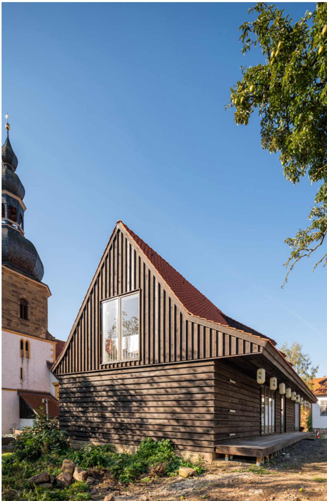
Abb. 3: Sch(D)afstall in Bedheim: Das Studio Gründer Kirfel mit Sitz in Bedheim sowie Zimmerleute und mehrere DesignBuild-Studios bauten auf den Grundmauern eines früheren Schafstalls auf dem Schlossgelände an einem Wirtschaftsgebäude. Der Sch(D)afstall ist ein Projekt der IBA Thüringen und wurde im Oktober 2018 fertiggestellt.
