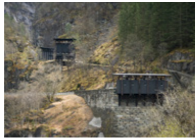
Ryfylke · Allmannajuvet Galerie, Bergwerkcafé, Toilette, Parkplatz, Pfade und Treppen Atelier Peter Zumthor & Partner Fredrik Fløgstad
